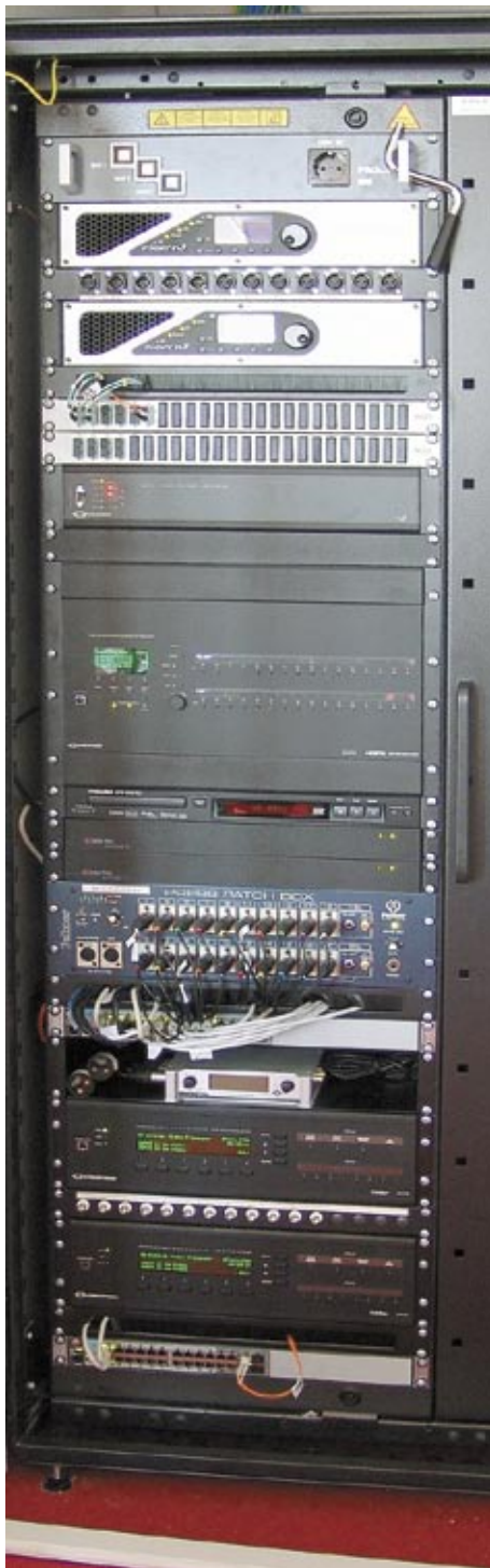
Links: Zwei Beispiele der im Text erwähnten Schaltschränke. Aus Platzgründen muss ich mich hier auf diese beiden Bilder beschränken, es gibt in allen Beschallungszonen eigene Schaltschränke, so z. B. auch im abgebildeten Fraktionssaal zwei Stück mit Riedel RockNet Interfaces, Pressesplitter, Univox Induktionsscheifen-Verstärker, Media Matrix und mehr.
