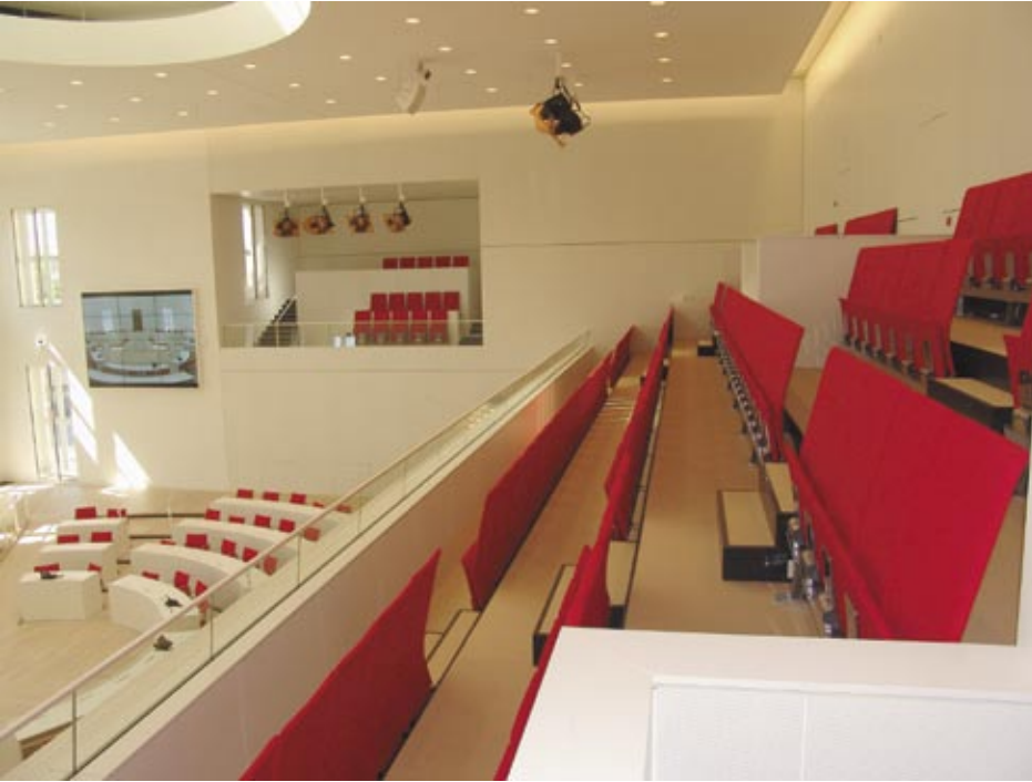
Blick von der Zuschauer- zur Presstribüne. Die Presstribüne hat ihr eigenes Soundsystem in Form von Flächenlautsprechern, die aber komplett unsichtbar angebracht sind. Über der Presstribüne ist ein Delaysystem für die Zuschauer so eben zu erkennen. (weiss in weiss fotografiert sich nun mal nicht so gut...)
