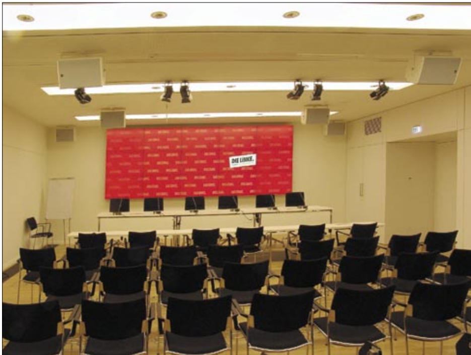
Die Fraktionssäle sind alle gleich ausgestattet. Insgesamt sind sechs Lautsprecherboxen zu erkennen, die vier im Vordergrund sind die eigentliche Beschallung für den allgemeinen Sitzungsablauf. Die Boxen ganz hinten an der Wand würden, wenn sie auch zu diesem Zweck gebraucht würden ein erhebliches Feedback verursachen, das tun sie aber nicht, weil sie ausschliesslich für die Wiedergabe des Videotons gedacht sind.
