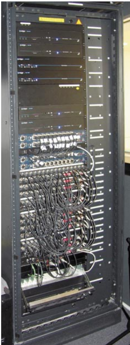
Links: Zwei Beispiele der im Text erwähnten Schaltschränke. Aus Platzgründen muss ich mich hier auf diese beiden Bilder beschränken, es gibt in allen Beschallungszonen eigene Schaltschränke, so z. B. auch im abgebildeten Fraktionssaal zwei Stück mit Riedel RockNet Interfaces, Pressesplitter, Univox Induktionsscheifen-Verstärker, Media Matrix und mehr.
