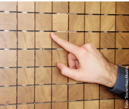
Holz auf Holz. Ein Gitterrost aus schmalen Holzleisten ergab eine deutlich bessere Statik für die Holzklötzchen.
